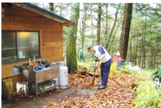
屋根大改修 屋根板の葺き替え
